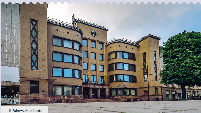
Il Palazzo delle Poste
