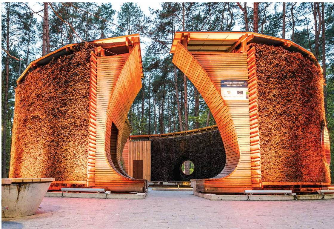
Башня для выпаривания минеральной воды в Бирштонасе
